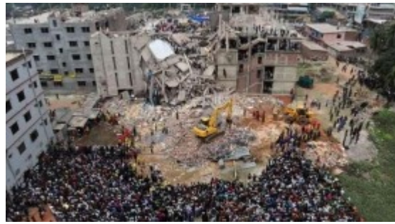
Effondrement du Rana Plaza, usine textile au Bangladesh pour la franchise H&M, 24 avril 2013. © Munir Uz Zaman
